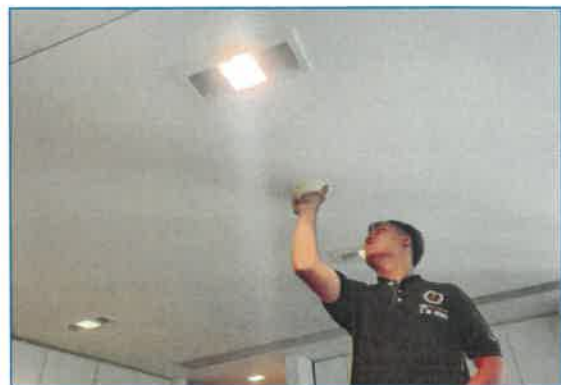
ภาพถ่ายที่ 2.2-20 เจ้าหน้าที่ตรวจเช็คระบบป้องกันอัคคีภัย
